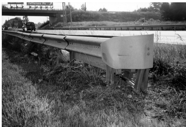
شکل پ ۳-۲- ضربه‌گیر برک ماستر ۳۵۰
