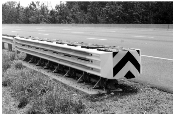
شکل پ ۳-۶- ضربه‌گیر کواد گارد استاندارد
