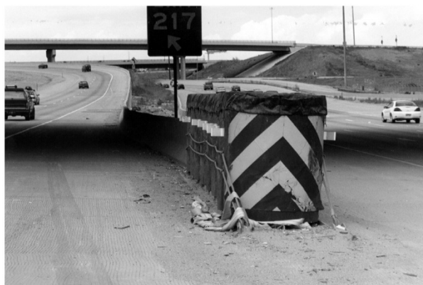
شکل پ ۳-۹- ضربه‌گیر جذبی باز کاربرد
