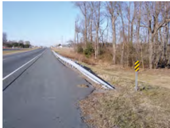
شکل ۲-۱۰- بالای شکل کردن و فرو بردن انتهای حفاظ در زمین
