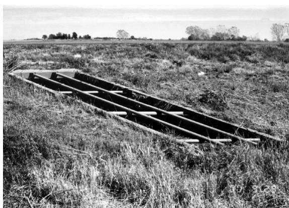
نمونه‌ای از قابل عبور کردن آبروی عرضی
